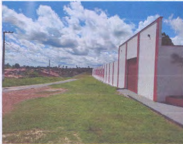
Imagem 03: Entorno do estádio como se encontra atualmente.
