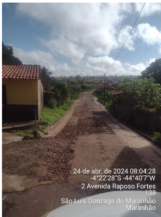
FOTO 1: INÍCIO DA OBRA.
