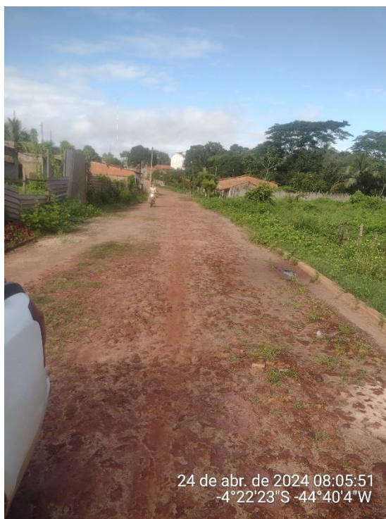
FOTO 2: RUA MAROCA, MEIO DA RUA.
